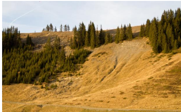
Le glissement de l'Airon, sur une écaille de terrains olistolitiques
