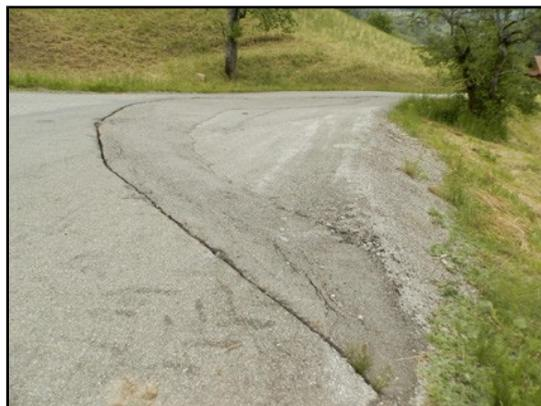
Figure 49: Affaissement de la chaussée au lieu-dit "les Rasses"
