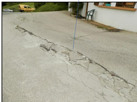
Figure 51: Affaissement de la route privée à l'amont du glissement
